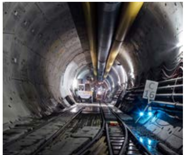
Der Koralmtunnel wird der sechstlängste Eisenbahntunnel der Welt.
