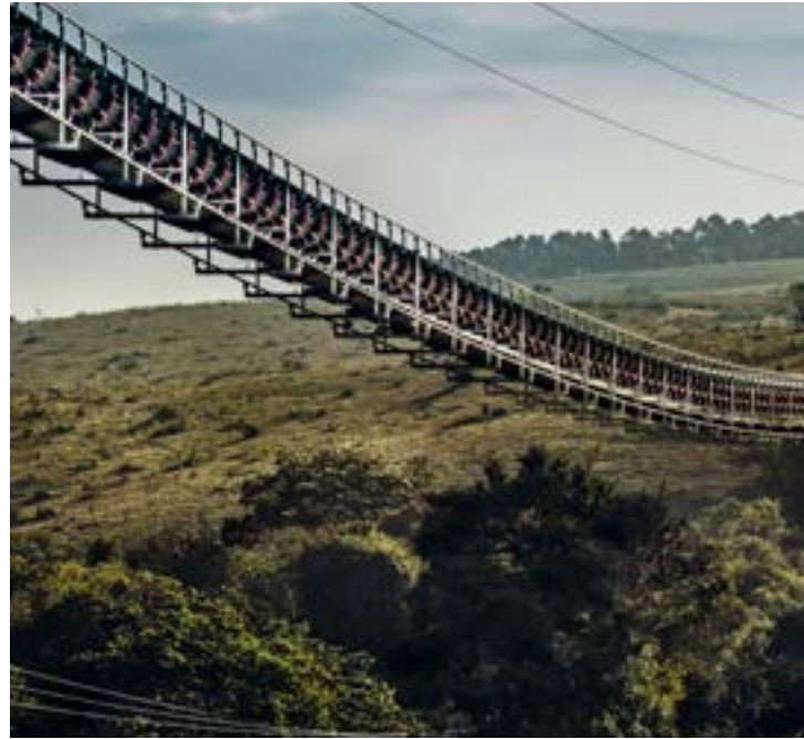
Der Flying Belt transportiert im brasilianischen Bergland tausende Tonnen Kalkstein pro Stunde.
